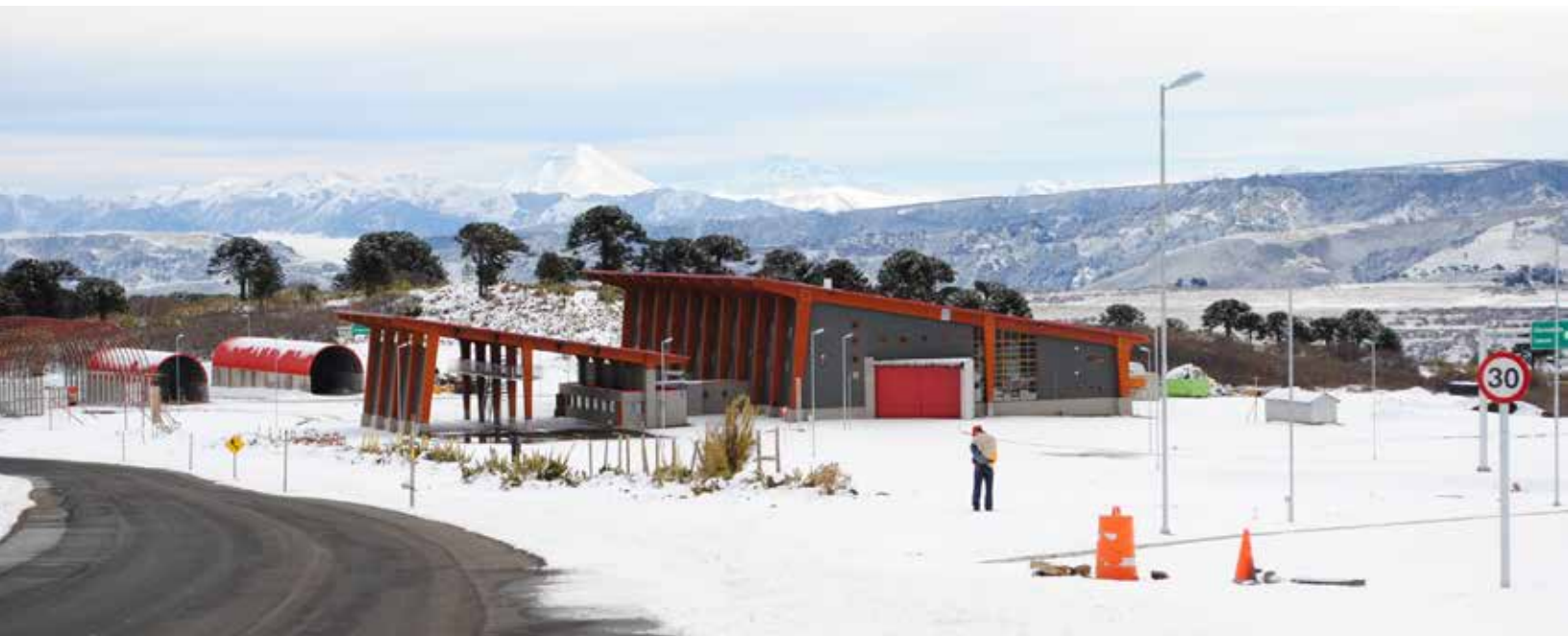
Complejo Fronterizo Pino Hachado, Región de la Araucanía
